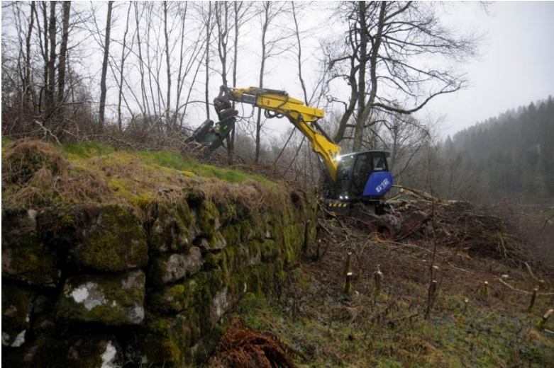
Der Schreitbagger in Aktion - Freistellung einer Trockenmauer im mittleren Hangbereich. © A. Koch
